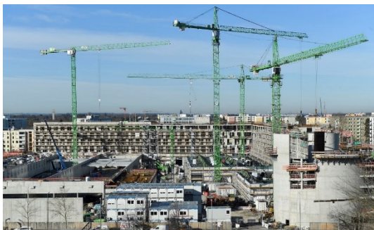
Aktuelle Vogelperspektive auf die Baustelle des Hybrid.M
