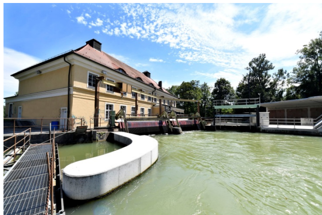
Der neue Betonpfeiler im Vordergrund sorgt für mehr Ökostrom.
