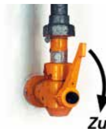
Hauptabsperreinrichtung (Feuerhahn)
