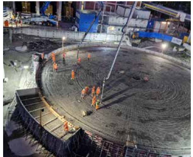
Ein wichtiger Baustein für die Wärmewende: 2023 wurde am Energiestandort Süd mit dem Bau eines Wärmespeichers begonnen.
