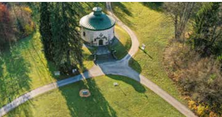
Nur mit Fahrrad oder zu Fuß zu erreichen: Die Grundwasserfassung Reisach liegt mitten im Wasserschutzgebiet.
