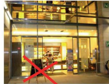
Abb. I-3: Positiv-Beispiel Glasfassade (U-Bahnhof Oberwiesefeld), jedoch Angebotsstände außen
