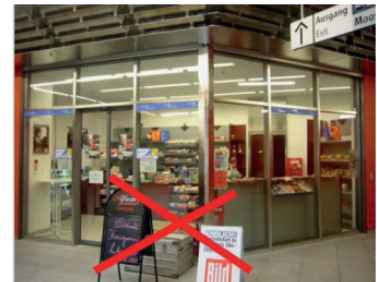
Abb. I-2: Positiv-Beispiel Glasfassade (U-Bahnhof Oberwiesenfeld), jedoch Angebotsständer außen
