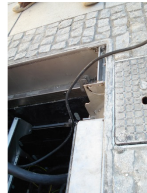
Kabel durch den geöffneten Kabelauslass legen
