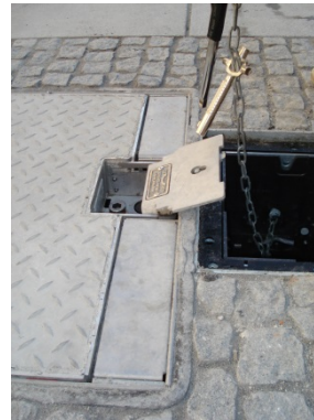
Geöffneter Schutzdeckel mit Blick auf den 14 mm Inbus
