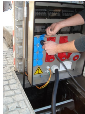
Kabel an der entsprechenden Steckdose anstecken
