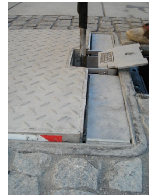
Hauptschacht öffnen mit 14 mm Inbus durch Linksdrehungen
