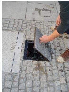
Schlüsselschacht öffnen für die Entnahme der Schlüssel
