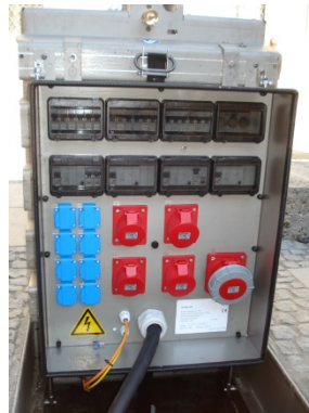
Verteilungsbekleidung 1 x 63 A, 2 x 32 A, 2 x 16 A, 8 x Schuko, max. 53 kVA
