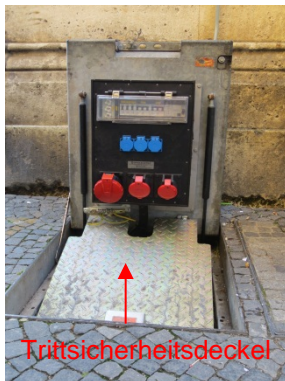
Verteilungsbestückung 1 x 63 A, 1 x 32 A, 1 x 16 A 3 x Schuko, max. 53 kVA
