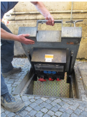
90° aufziehen, bis Trittsicherheitsdeckel einrastet
