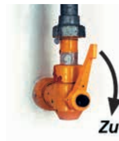
Hauptabsperreinrichtung (Feuerhahn)
