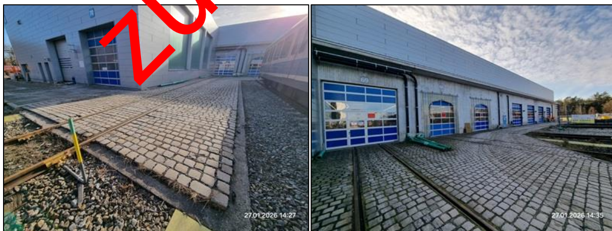
Abbildung 7: Bauabschnitt Rot – Foto Gleise BN63 bis BN69 Nord Bestand.
